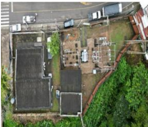
Vista aérea Subestación Norcasia (Norcasia – Caldas)
