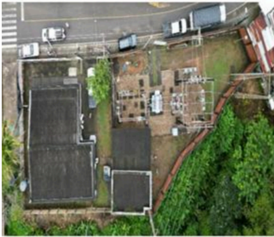
Vista aérea Subestación Norcasia (Norcasia – Caldas)
