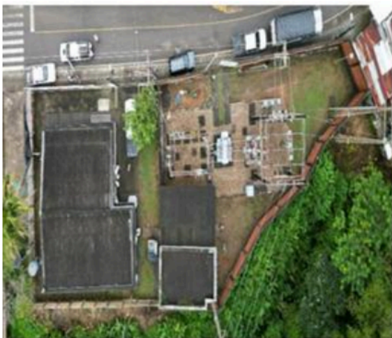
Vista aérea Subestación Norcasia (Norcasia – Caldas)
