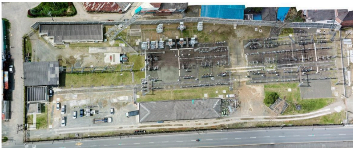
*Vista aérea Subestación La Rosa – Municipio de Dosquebradas
