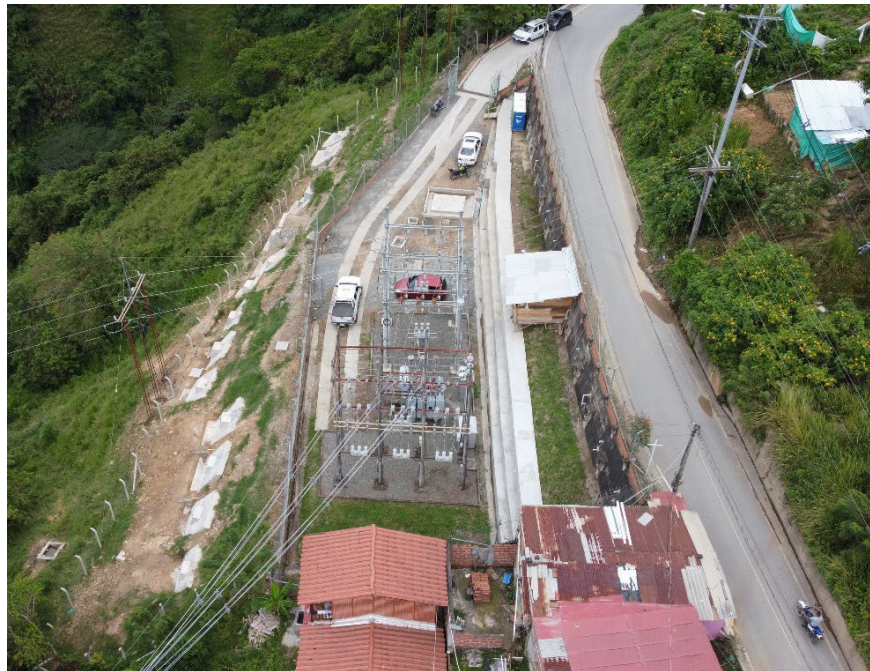
*Vista aérea Subestación El Dorado (Marmato – Caldas)
