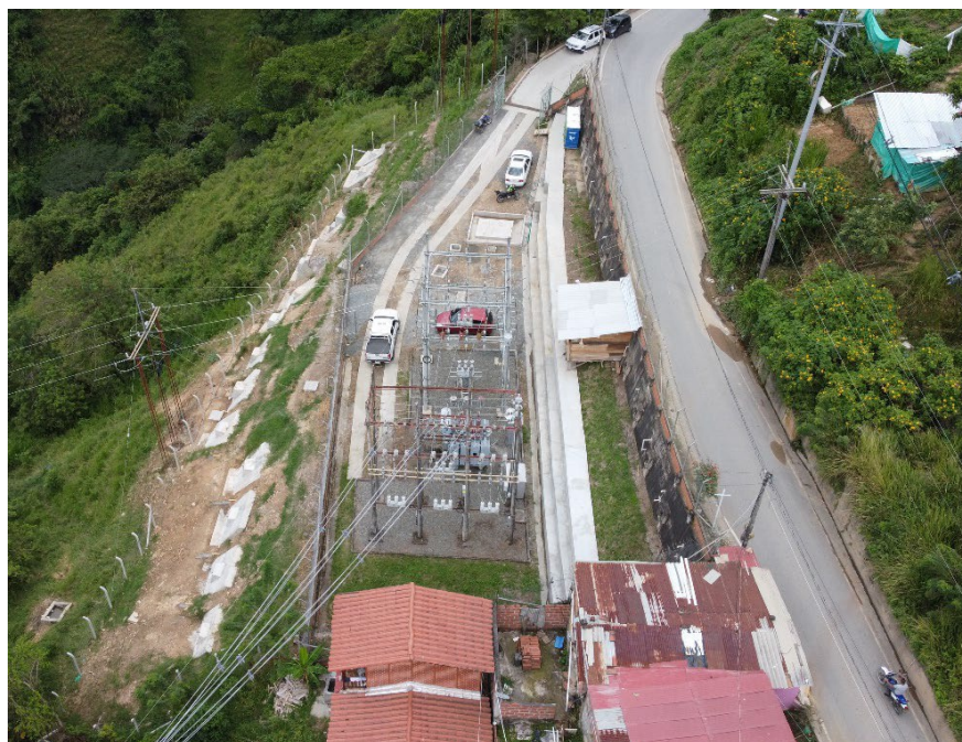
*Vista aérea Subestación El Dorado (Marmato – Caldas)
