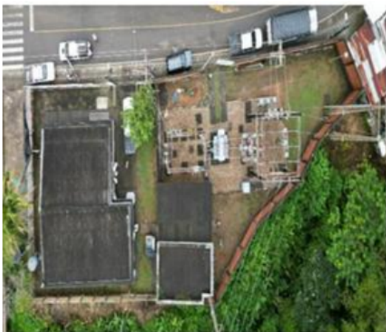
Vista aérea Subestación Norcasia (Norcasia – Caldas)
