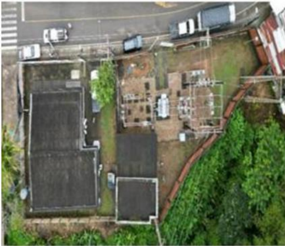
Vista aérea Subestación Norcasia (Norcasia – Caldas)
