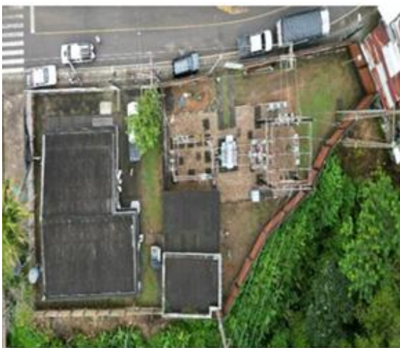
Vista aérea Subestación Norcasia (Norcasia – Caldas)
