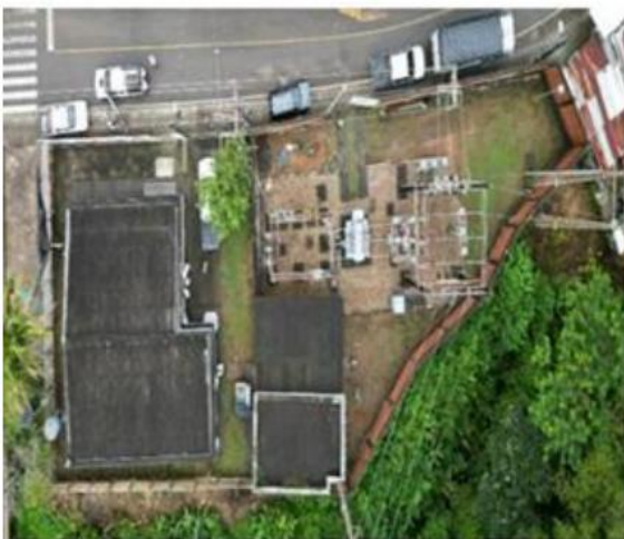
Vista aérea Subestación Norcasia (Norcasia – Caldas)
