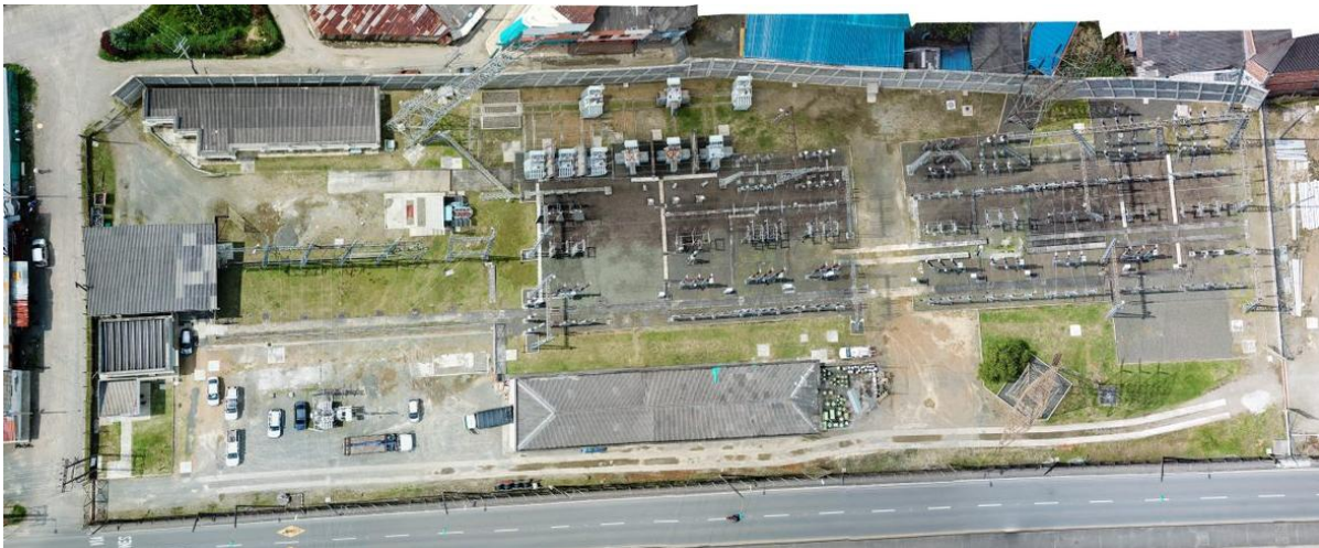
*Vista aérea Subestación La Rosa – Municipio de Dosquebradas
