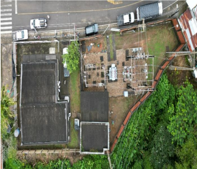
*Vista aérea Subestación Norcasia (Norcasia – Caldas)
