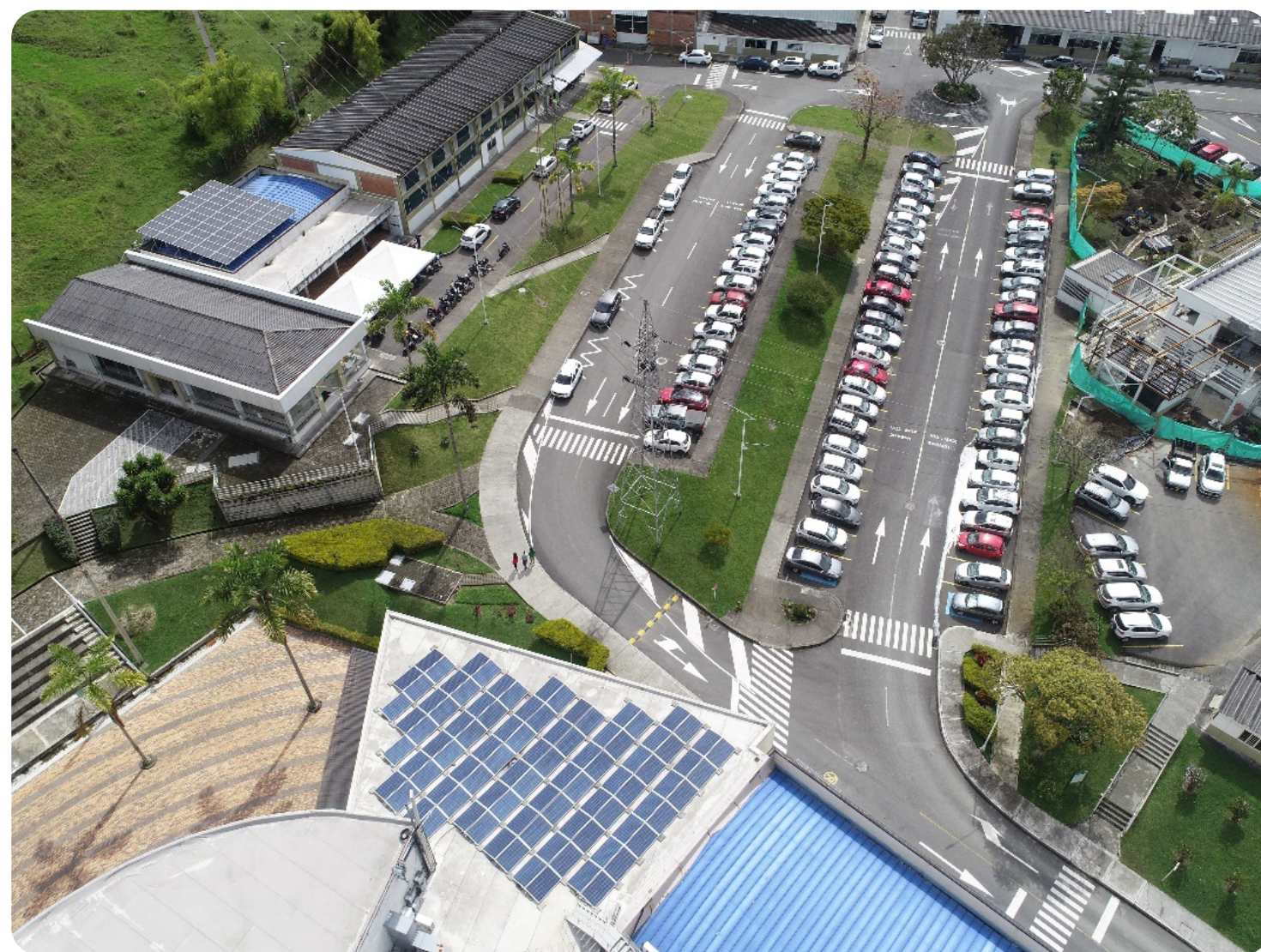
Sistemas solares fotovoltaicos Estación Uribe, Manizales
