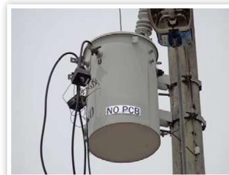
Marcación de transformadores como NO PCB bajo la Norma Técnica de marcación EPM RA7-034
