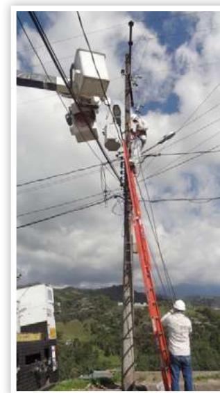
Cambio de transformador contaminado con PCB, con carro canasta.
