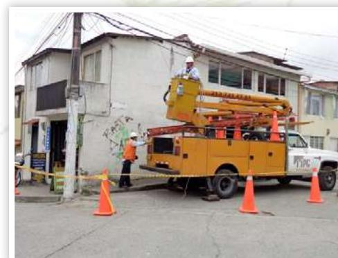
Procedimiento de toma de muestras de aceite en transformadores de distribución en poste para pruebas de PCB.
