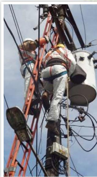
Cambio de transformador contaminado sin PCB, sin carro canasta
